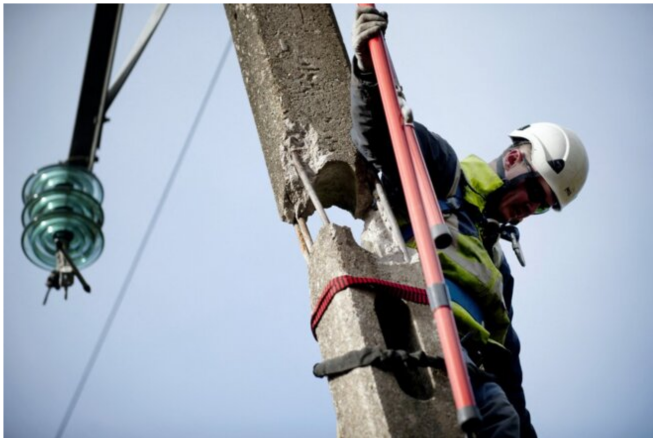
Intervention d'un agent d'Enedis sur le réseau d'électricité en 2014. © Photo Jean-Sébastien Evard / AFP
