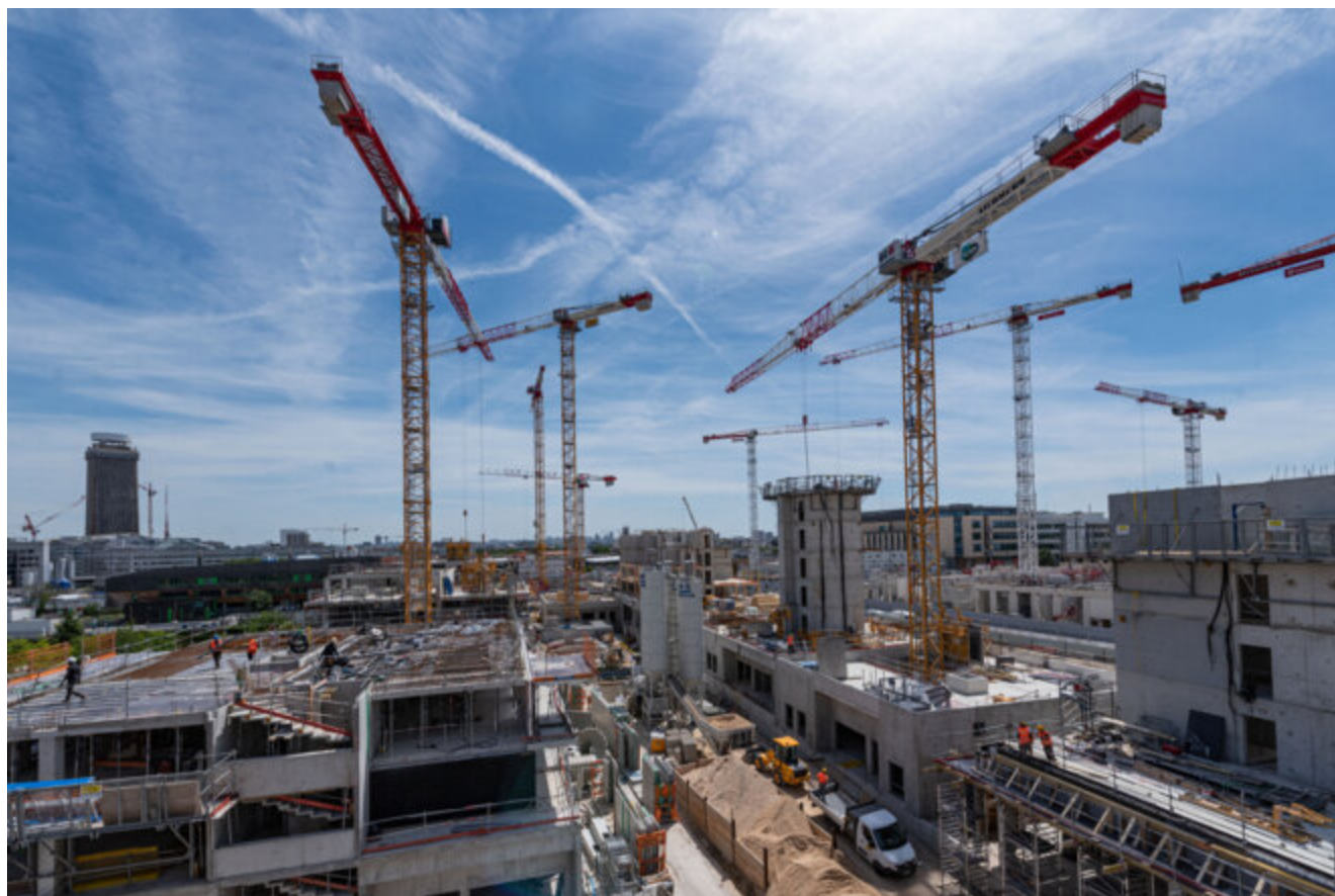
Chantier du village olympique de 2024, à Saint-Denis, le 14 juin 2022. © Photo Arnaud Paillard / Hans Lucas via AFP
