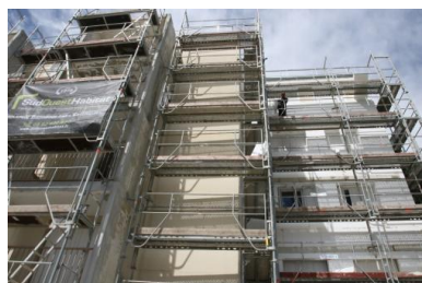
À Auch (Gers), un chantier de rénovation de HLM. © Sébastien Lapeyrière/Hans Lucas/AFP
