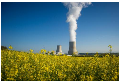
La centrale nucléaire de Civaux. © Photo Guillaume Souvant / AFP
