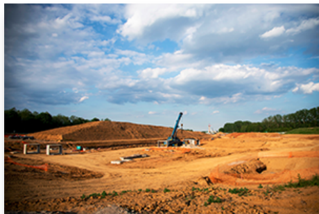
Les travaux de bétonisation sur le plateau de Saclay (Essonne), en juin 2021. © NnoMan/Reporterre
