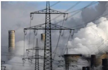
Centrale à charbon de RWE à Weisweiler (Allemagne). © Ina Fassbender / AFP
