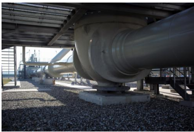
Sur le chantier du gazoduc Nord Stream 2. © Photo Ekaterina Solovyova / Sputnik via AFP
