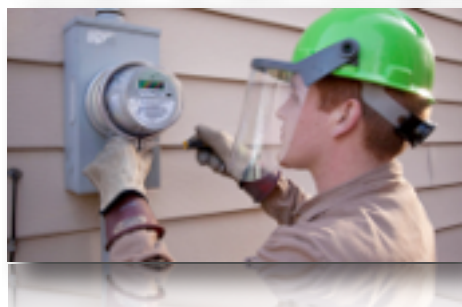
Installation d'un nouveau compteur intelligent.
