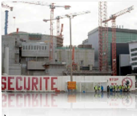
Chantier de l'EPR à Flamanville © Reuters
