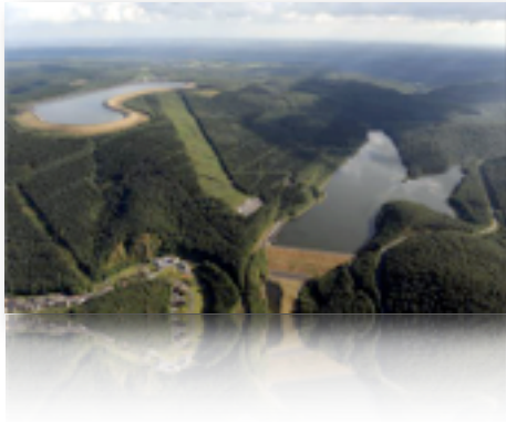
La station de transfert d'énergie par pompage (Step) de Revin (Ardennes).
