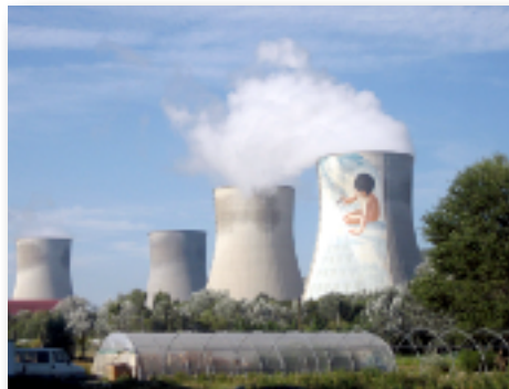
La centrale nucléaire de Cruas, en Ardèche.
