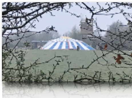
L'un des premiers lieux évacués, le Lama fâché, sur la RD281, à proximité des Cent Noms. © CG
