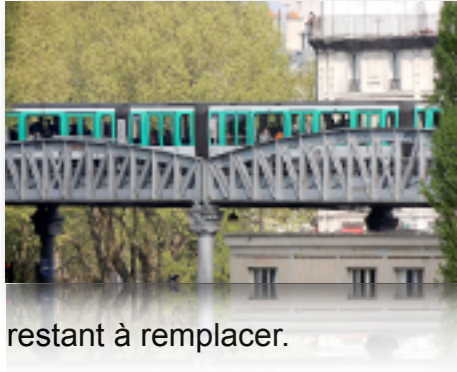
Une section aérienne du métro parisienne, près de la station Jaurès.
