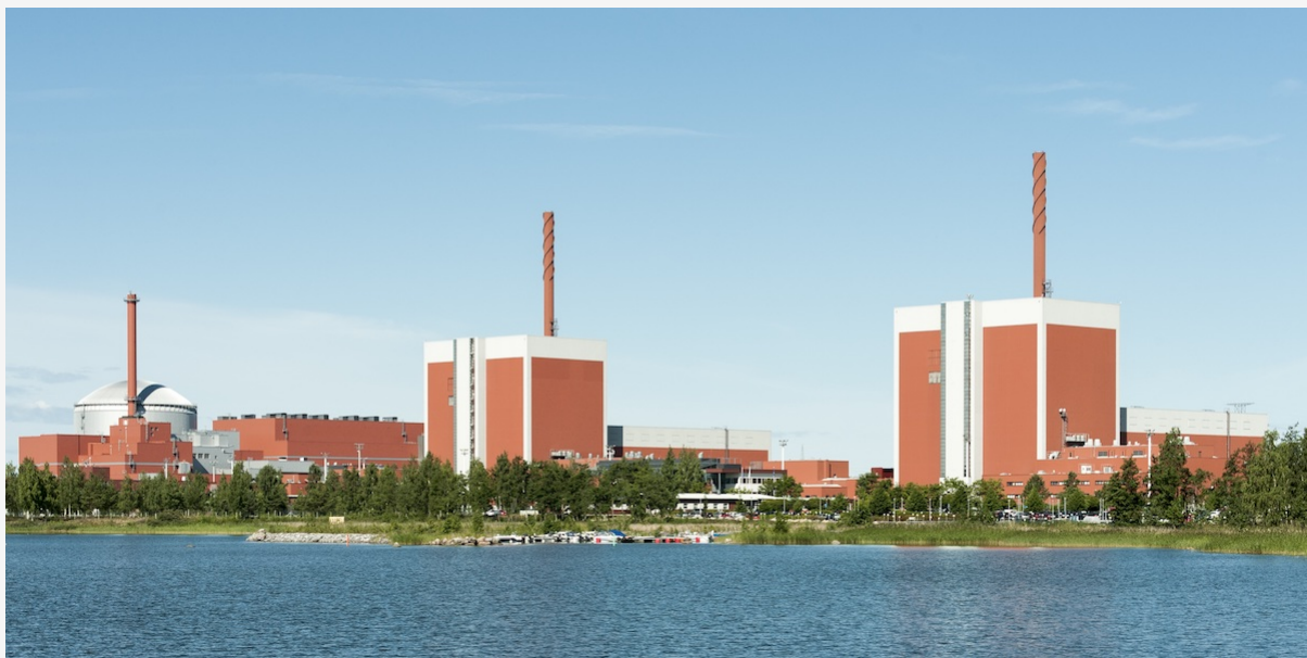
Les deux réacteurs en activité de la centrale finlandaise d'Olkiluoto, en 2015. Le troisième réacteur devrait être un EPR, mais sa construction accumule douze ans de retard et sa facture a triplé.
