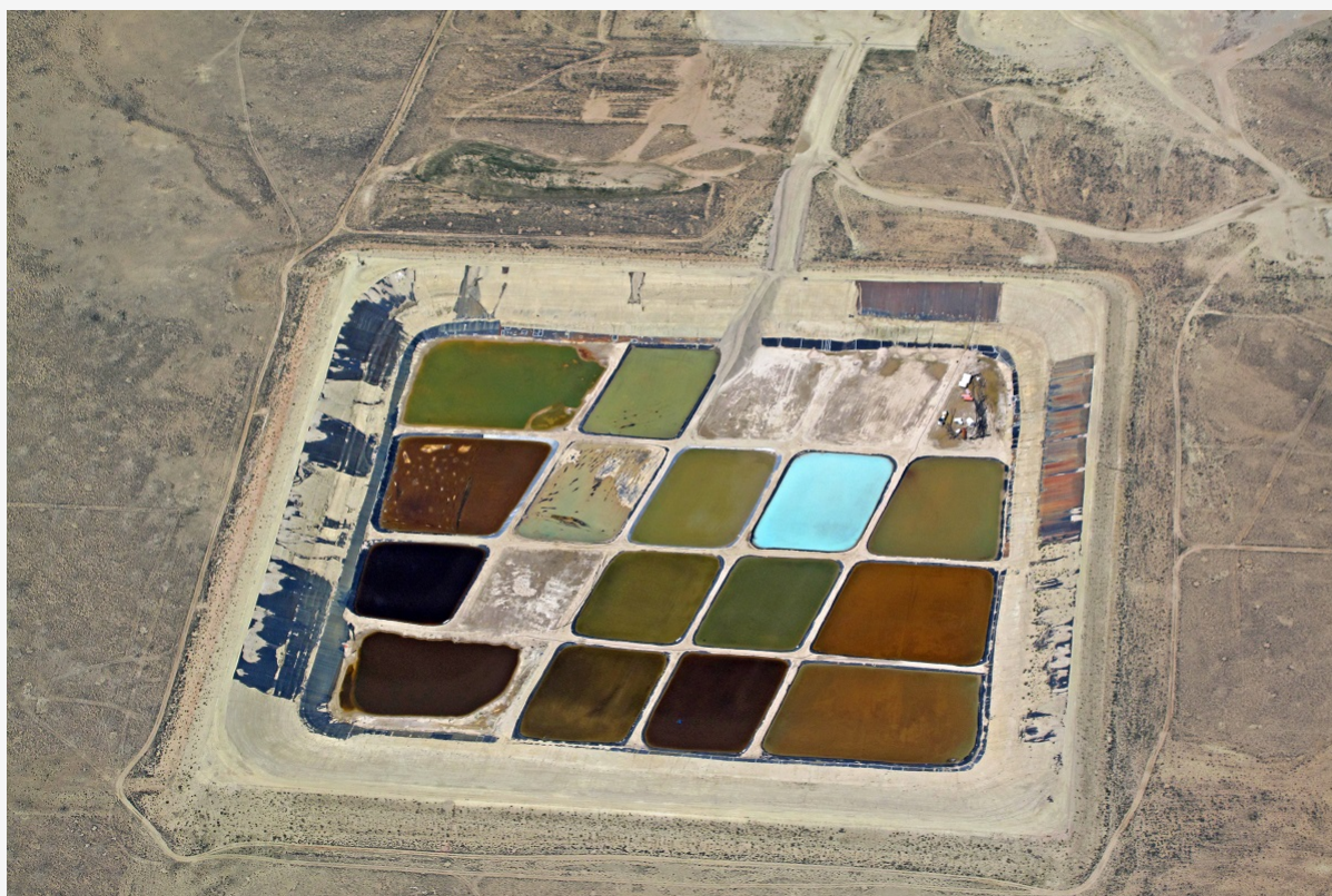
De gigantesques bassins recueillent les eaux — polluées — nécessaires à la fracturation hydraulique. Elles sont laissées à l'évaporation.
