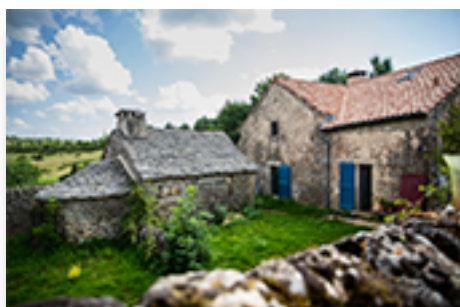
Une partie des bâtiments de la ferme de Romain et Marion, avec des toits fraîchement rénovés. © David Richard / Reporterre
